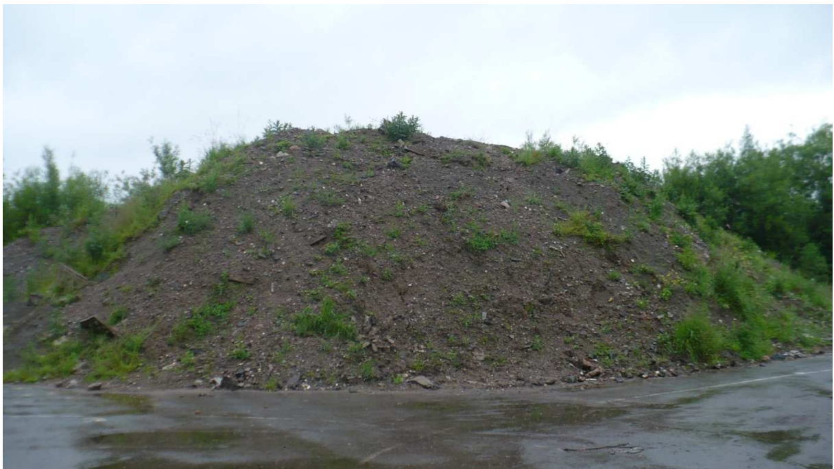
Fot. 2. Hałda materiału ziemnego (na warstwę rekultywacyjną-właściwą)
