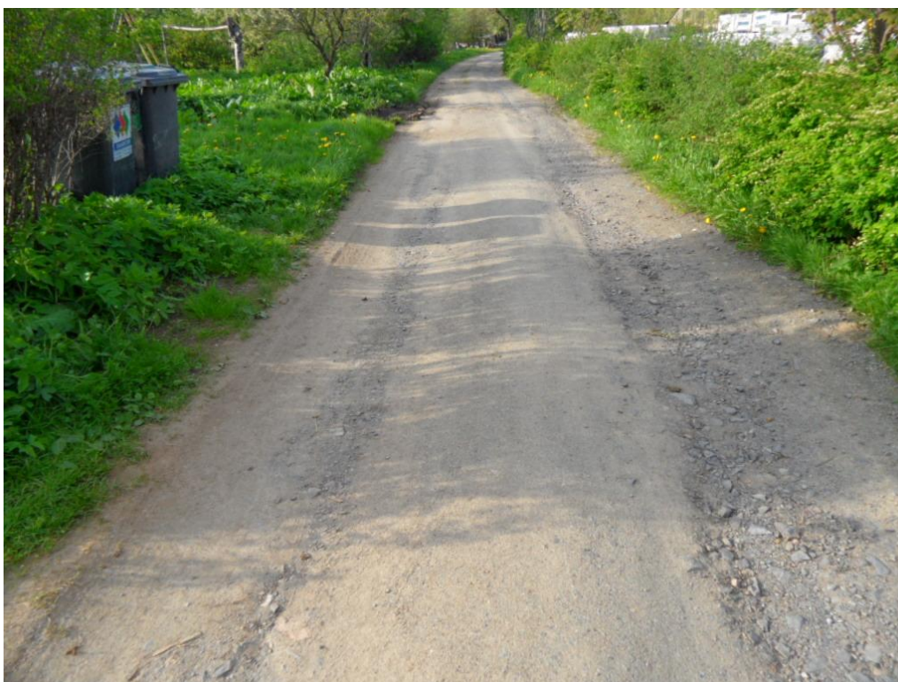
Fot. 2. Widok odcina drogi o nawierzchni tłuczniowej
