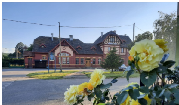
Dworzec kolejowy w Marciszowie
