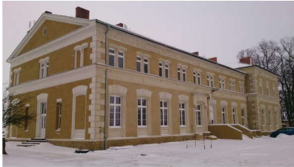
Dworzec kolejowy w Sędzistawiu, 2017 r. Źródło: http://tomaszrogus.pl/wp-content/uploads/2017/04/DSC_3022-1024x576.jpg
