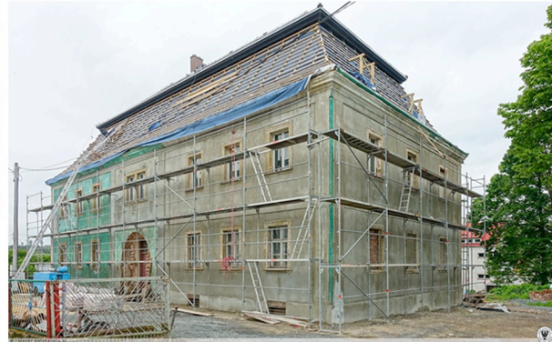
Rysunek 24 Freski ściennie, Pałac w Ciechanowicach Rysunek 25 Dwór w Sędziszawiu w trakcie remontu
