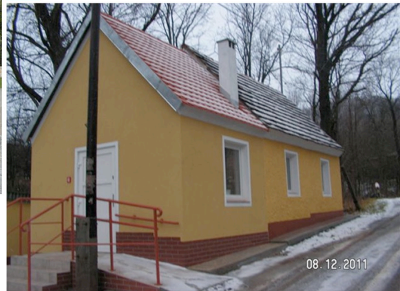
Rysunek 10 Świetlica wiejska w Ciechanowicach
