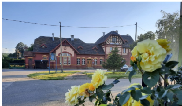
Dworzec kolejowy w Marciszowie
