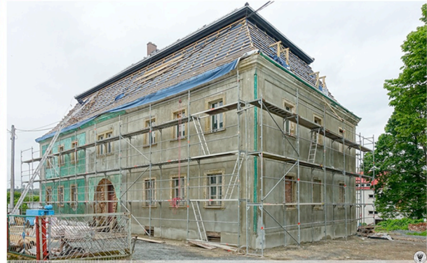
Rysunek 24 Freski ściennie, Pałac w Ciechanowicach Rysunek 25 Dwór w Sędzistawiu w trakcie remontu
