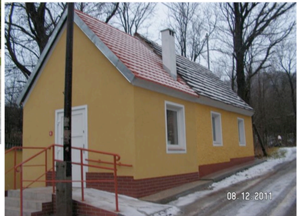
Rysunek 10 Świetlica wiejska w Ciechanowicach
