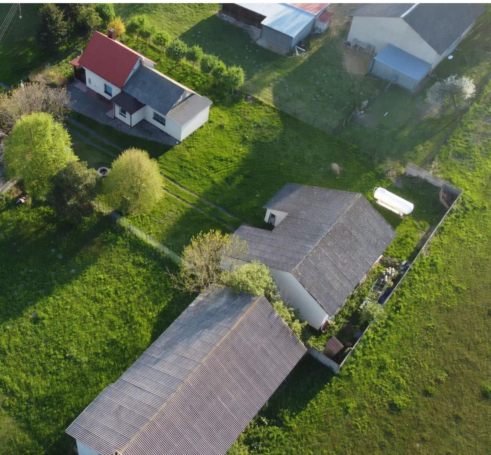
Fot. 1. Wykorzystanie wyrobów azbestowych jako pokrycia dachowe.
